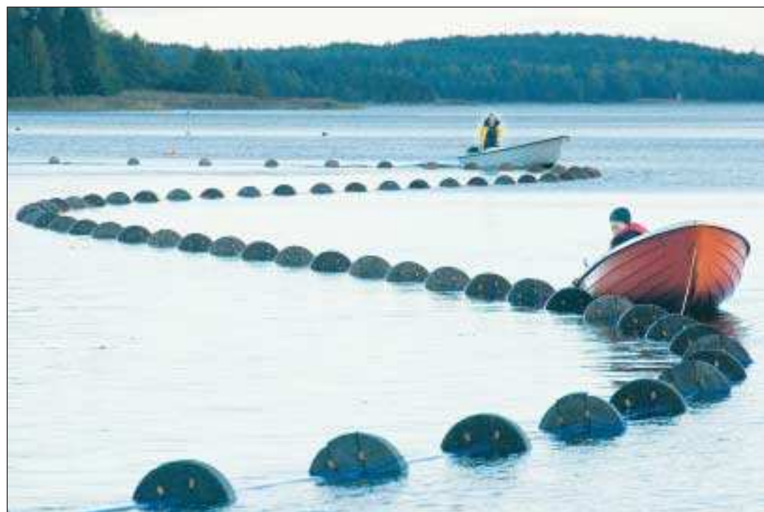
Förberett. Den första etappen består av 900 meter ledning, som svetsats ihop av Hebo rör.
