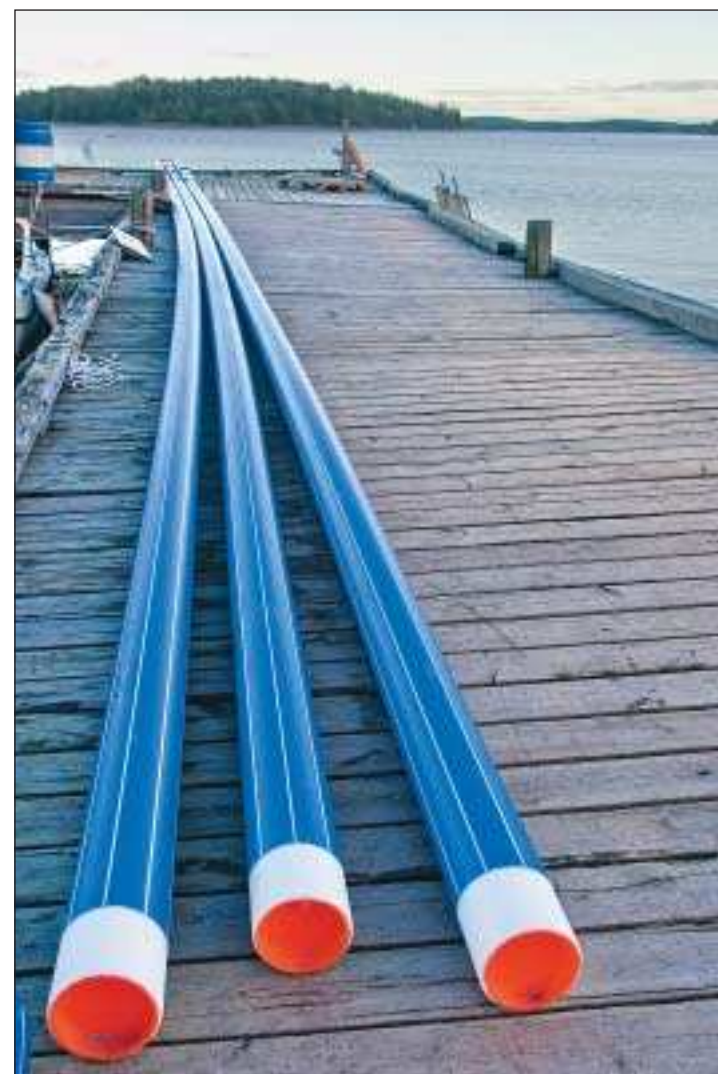
Stadigt. Det krävs 19,8 ton betongvikt för att hålla första ledningsetappen på plats på botten.
