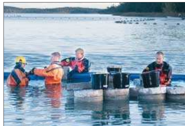
Tyngd. Daniel Salmi, Dykbolagets båda hälftenägare Gustav Nordström och Benny Gustafsson, samt Ove Jansson monterade betongvikterna i söndags. I dag bogseras ledningen ut över Prästö Sund.
