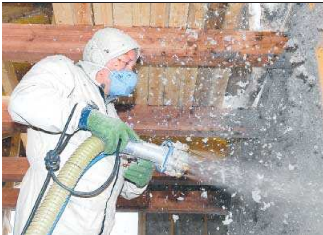
Julstämning? Det ser ut som stora snöflingor dalar när Bo Johansson isolerar Ekorexhuset med cellulul.
