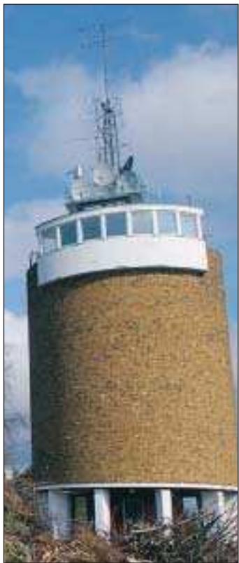
Jobb med centralenheten i vattentornet gör att det förekomma störningar i kabelnätet på dagtid den här veckan och nästa.
