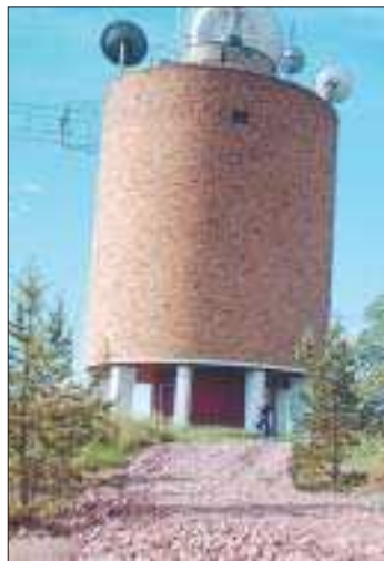
Mindre risk för störningar vid snöoväder och isbildning blir det när två parabolantennor på vattentornet nästa vecka byts ut till två med elvärme.
