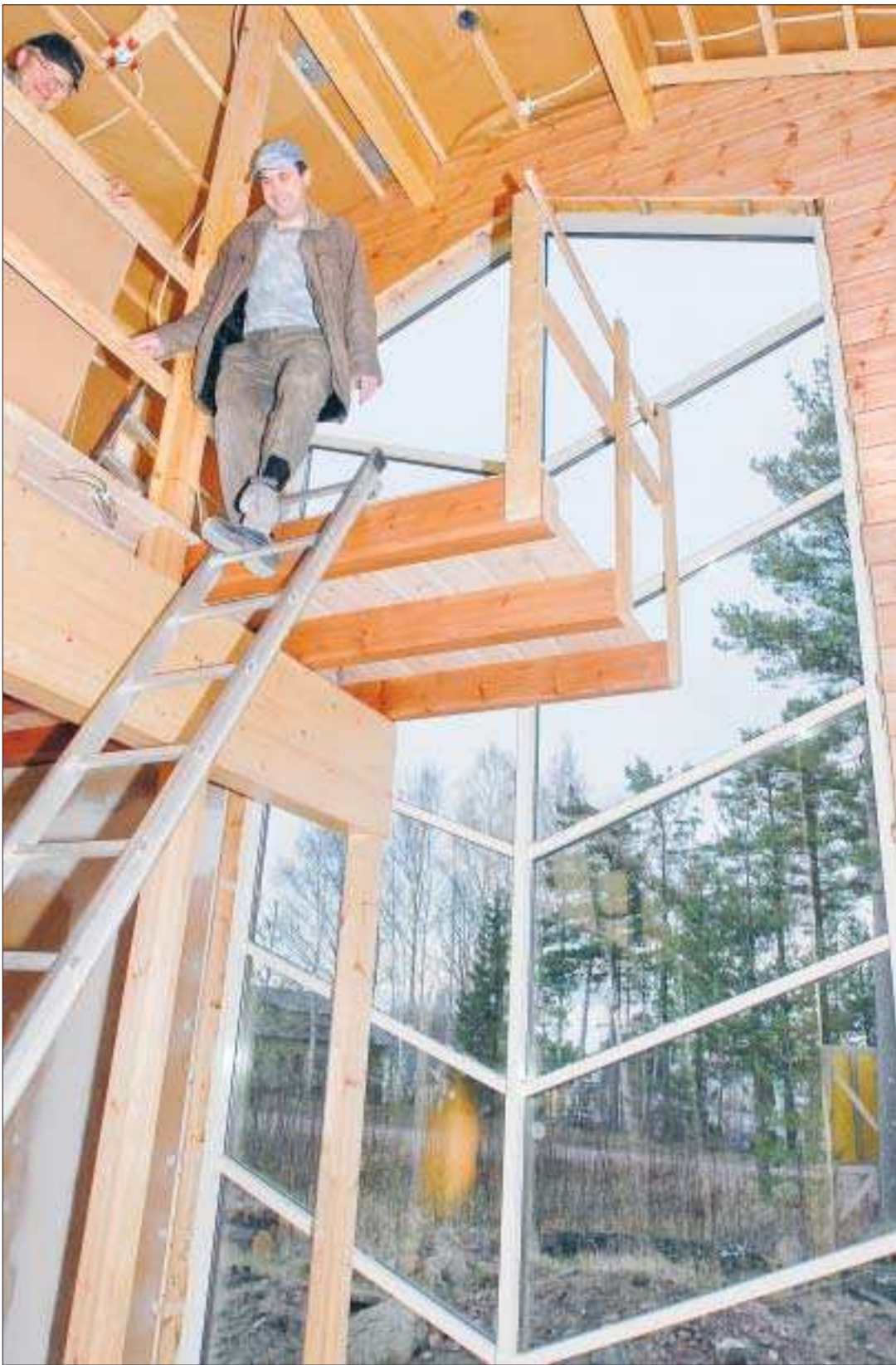
Flyttar in i januari. Randolph Bergendahl och Ainars Podnieks är inne på slutrakan med övervåningen, där kontoret ska inrymmas. Här uppe ska man lägga golv med en lite ovanligare konstruktion. Foto: ERKKI SANTAMALA
