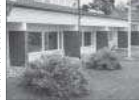
Sjukt hus? Flera av dem som vistas i Ålands vårdinstitut lider av symptom som rinnande näsor, huvudvärk och trötthet. 2001 mögelsanerades byggnaden. Nu skall man utreda vad som egentligen gjordes då och vad som eventuellt bör göras nu. Arkivfoto: ERKKI SANTAMALA
