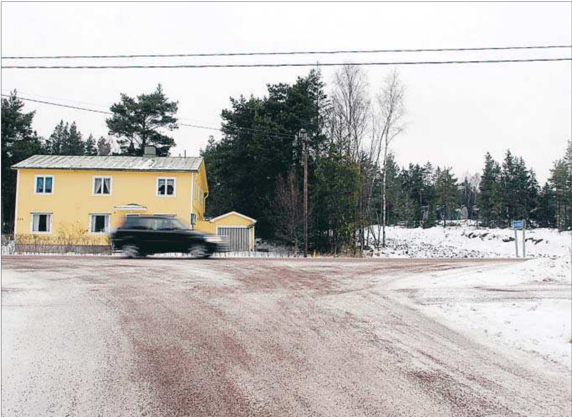
Rondell till bostäder. I det nuvarande vägskälet till Kalmarnäs planeras en rondell med fyra utfarter. Härifrån planeras även en ny avfart till bostadsområdet Solberget. Byggstart är satt till nästa år.
