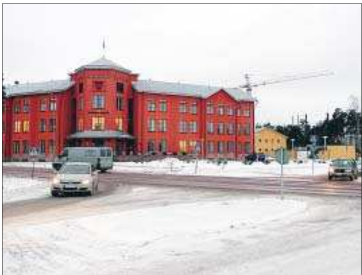
Bort med kaos. Kaos-korsning har den ibland kallats, korsningen Västra utfarten och Elverksgatan i Mariehamn. Rondell planeras även här, projekteringen ska göras i år.
