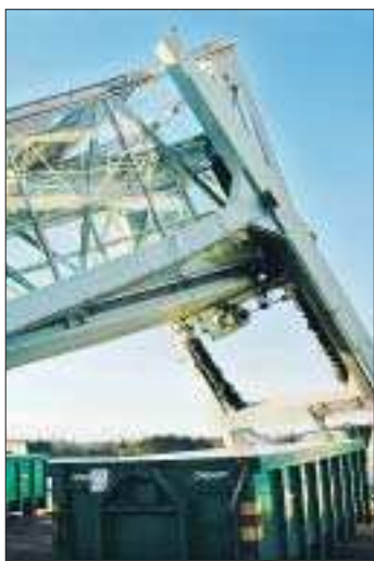
Landgången totalförstördes vid kollisionen.
