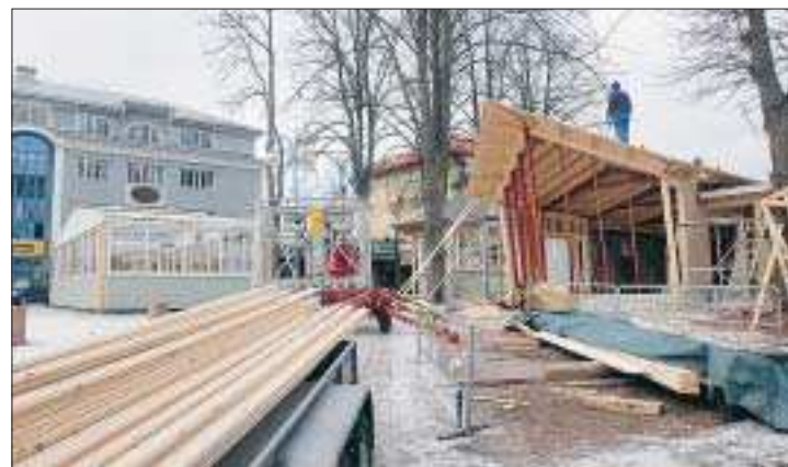
Full fart. Utbyggnaden av Eat på Torget i Mariehamn är i full gång. Här blir det i sommar en restaurang som har öppet också på kvällarna.
