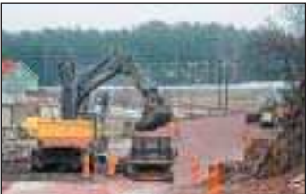
I Eckerö, mellan Böle och Storby, pågår ombyggnad av landsväg 1.
