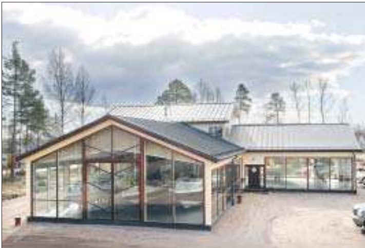
Miljö- och allergivänligt. Det har tagit ungefär ett år att färdigställa Ekorex-huset. Huset är byggt i timmer på gammalt sätt och ingen plast har använts. Ekorex-hus får använda finska Allergi- och Astmaförbundets samarbetsbeteckning.
