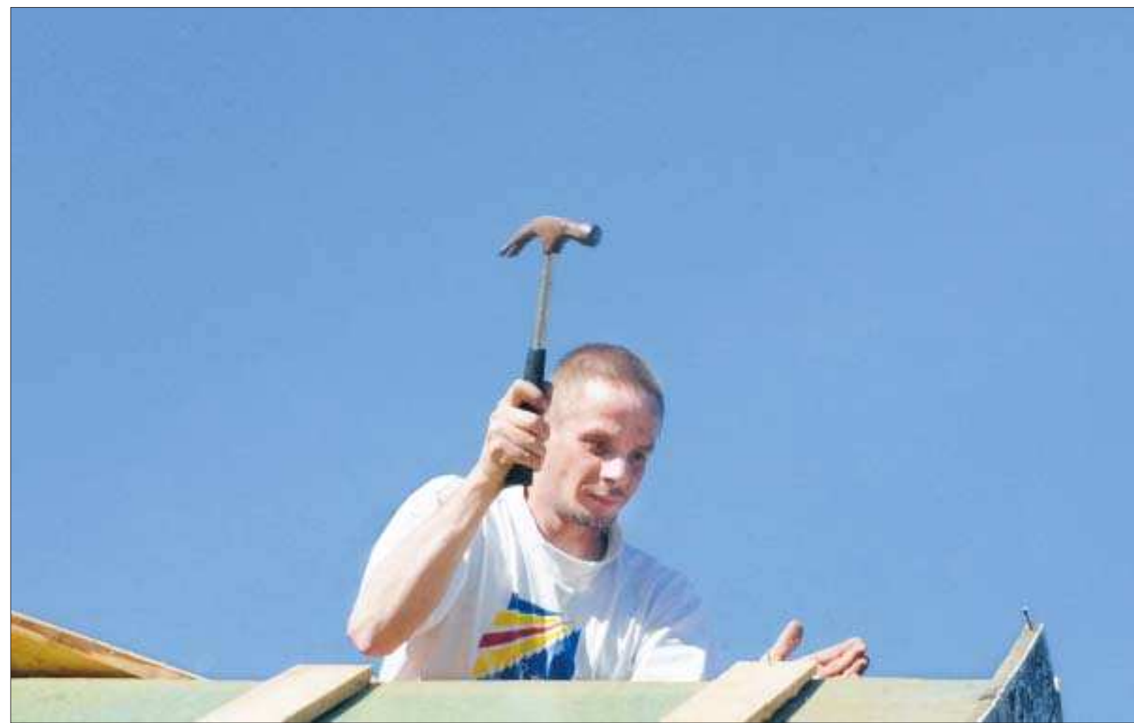
Uppå på taket. Robert Holmström är med och renoverar ett gammalt hus i Lumparland Svinö. Här skall byborna samlas i framtiden.
