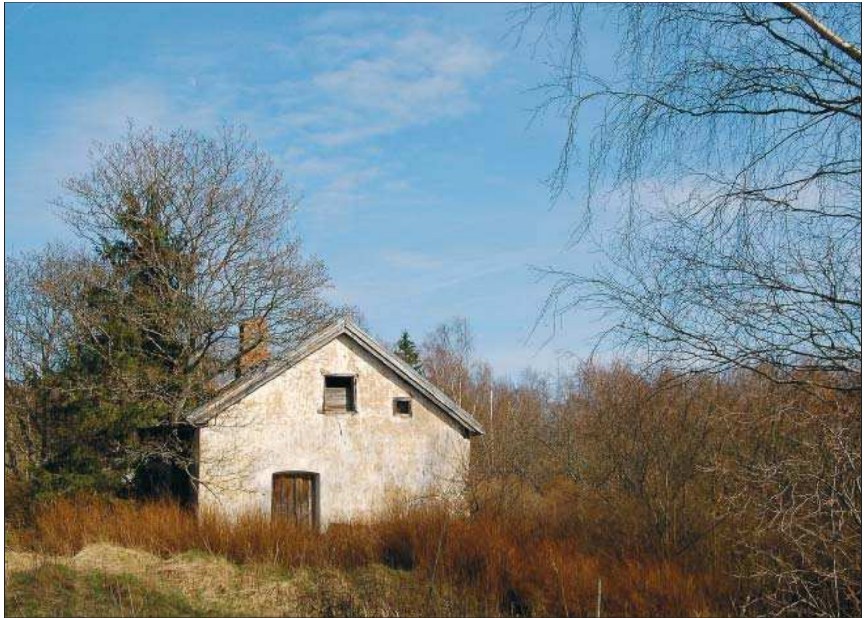
Stenhuset på Lustigkulla började byggas 1788 av makarna Henrik Mattsson och Greta Karlsdotter som mangård på det lilla hemmanet Lustigkulla i Främmanby, Saltvik. De var verkliga pionjärer. Det fanns knappt några stenhus alls i landskapet när de satte igång det mödosamma arbetet. Det välkända stenhuset i Tosarby uppfördes först i början av 1790-talet. Man kan undra vad som fick dem att satsa så djärvt på sin lilla bondgård. Det ovanliga och något herrgårdsaktiga namnet Lustigkulla torde gården ha fått av kyrkoherden 1773 när den anslogs åt Saltviks prästgård efter att ha legat öde sedan tidigt 1600-tal. Foto: Håkan Skogsjö (2007).
