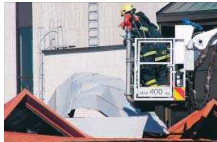
Lagade tak. Brandmännen på räddningsverket gav sig ut på ett lite annorlunda uppdrag i lördags då de spikade fast en lös plåt på ett hustak i centrala Mariehamn. Foto: JEPPE BERGVALL
