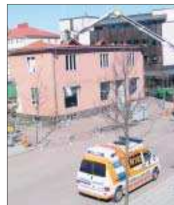
Med en brandbil med kran och en ambulans på plats såg det mer ut som ett räddningsuppdrag än en takreparation när räddningsverket ryckte ut i lördags. Foto: JEPPE BERGVALL
