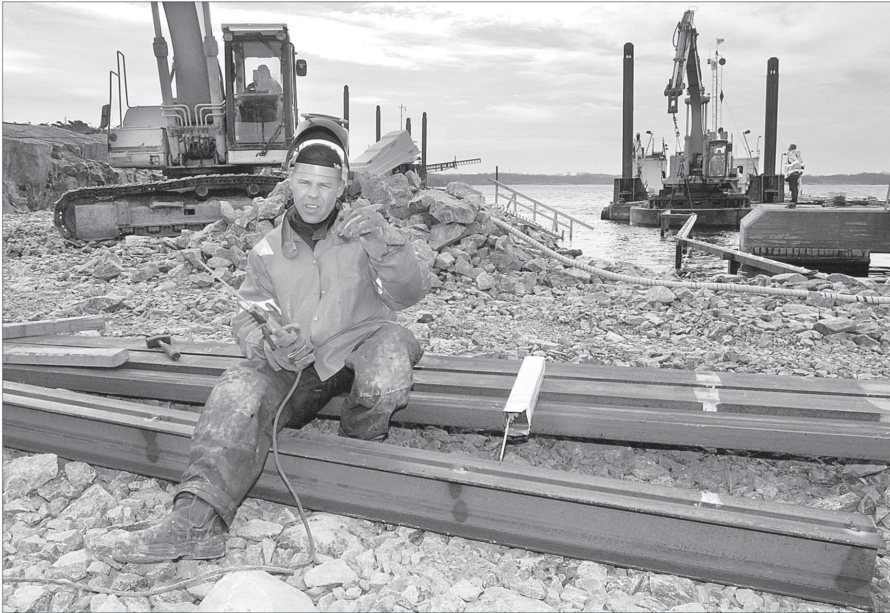
Gnister och dunder. Jaakko Virtanen från Terramare svetsar ihop stödbalkar för gjutformen som bryggan skall sitta fast i. Det nya färjfastet byggs innanför det gamla. Foto: ERKKI SANTAMALA
