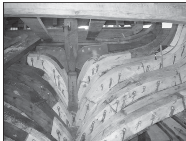
Skeppsbygge. Spanterna har förnyats och även i övrigt ersätts det mesta av trävirket i galeasen med nytt. Foto: STEN WESTERHOLM
