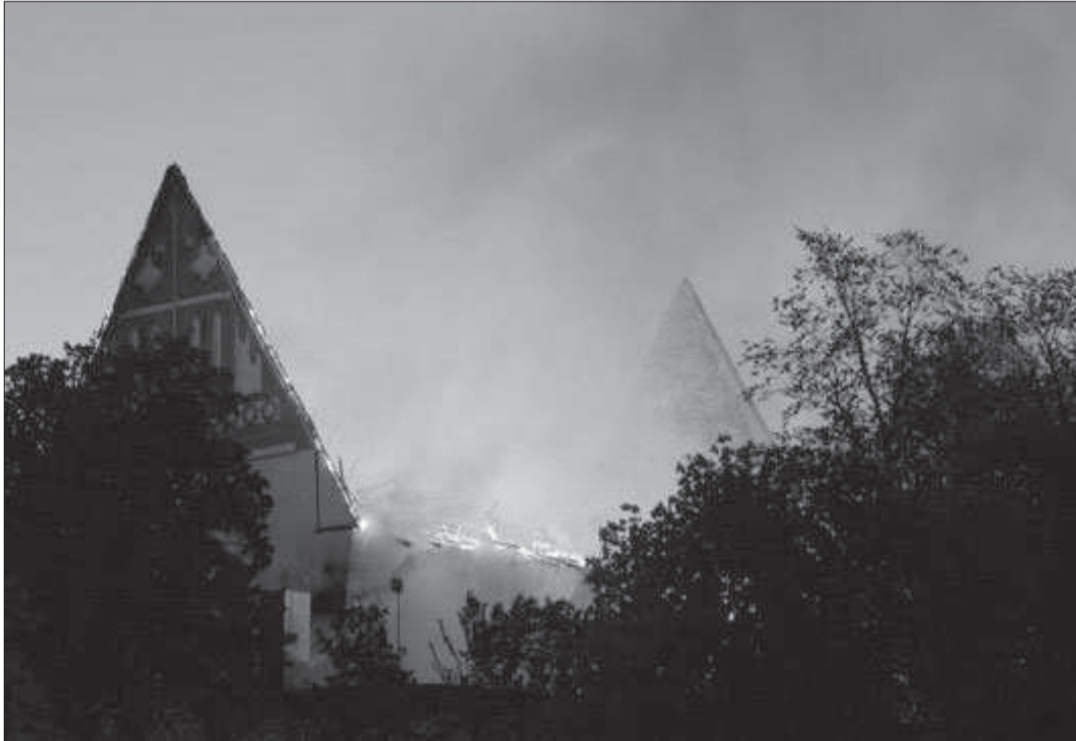
Byggs upp igen. Borgå domkyrka brann i maj ifjol. Planen för återuppbyggnaden är att kyrkan ska vara återställd senast till 200-årsfirandet av Borgå lantdag i mars 2009.
