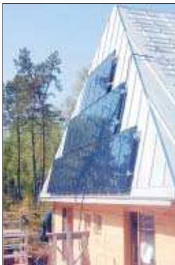
Varmt jobb. Johan Åminne svettas i solen när han monterar fästen för solpanelerna på det nya solhuset. De svarta panelerna mot söder är redan fästa. Redan i dag levererar panelerna ström till nätet.
