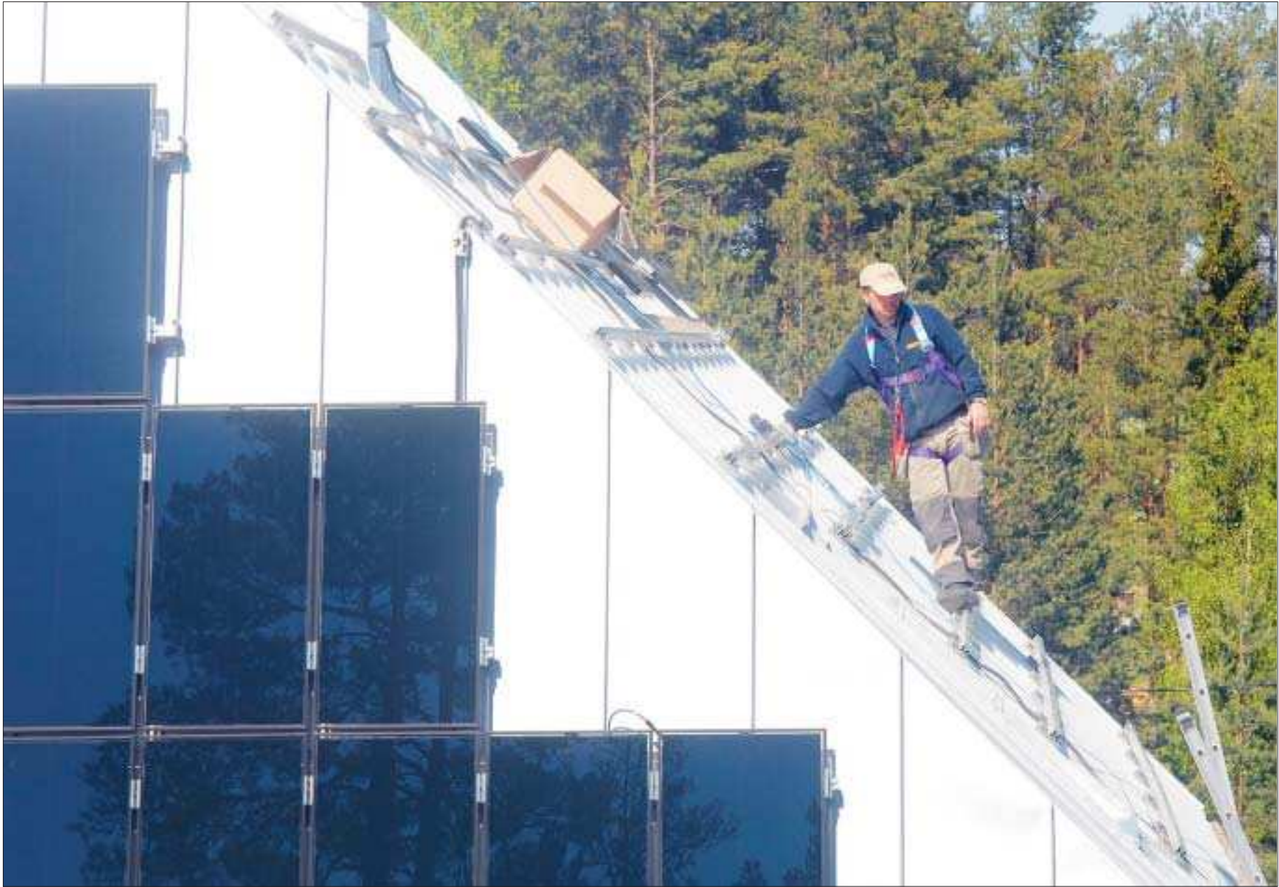
Varmt jobb. Johan Åminne svettas i solen när han monterar fästen för solpanelerna på det nya solhuset. De svarta panelerna mot söder är redan fästa. Redan i dag levererar panelerna ström till nätet.
