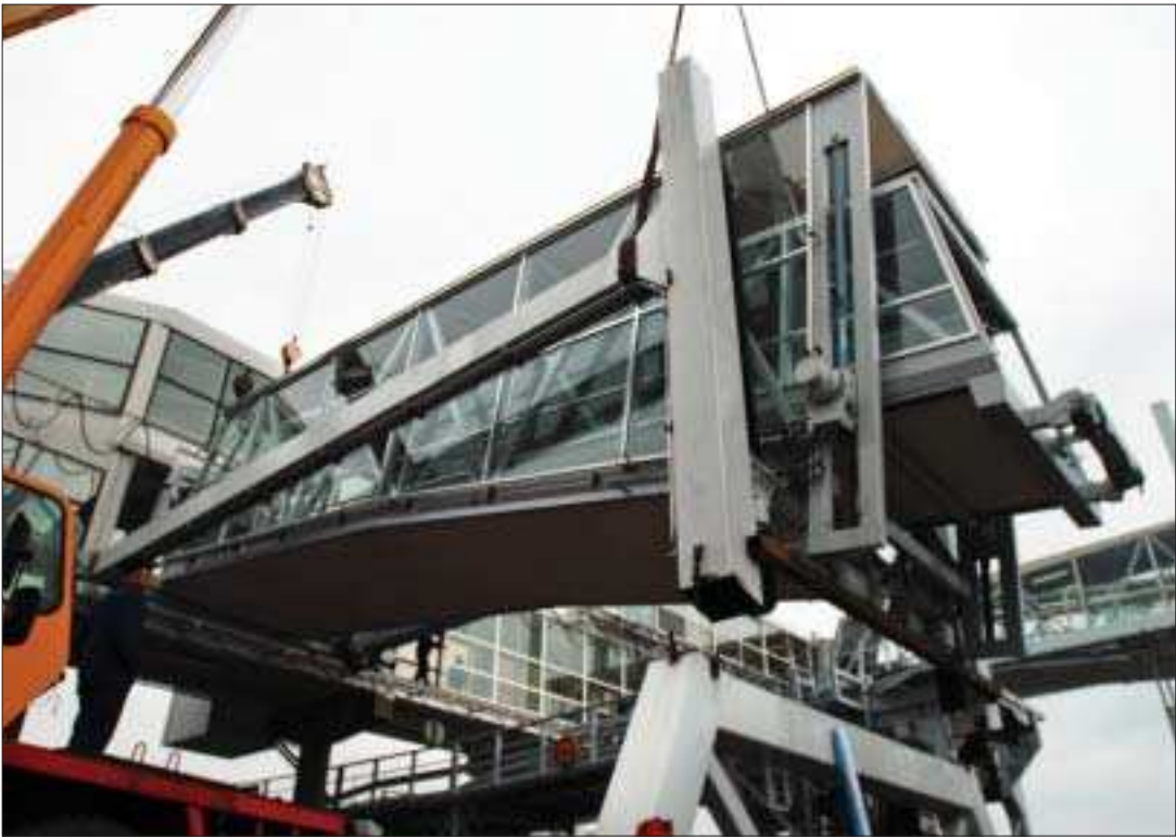
Nästan framme. Med god precision lyckades kranförarna snabbt få landgången på fundamenten. Foto: ANDREAS DIENERT
