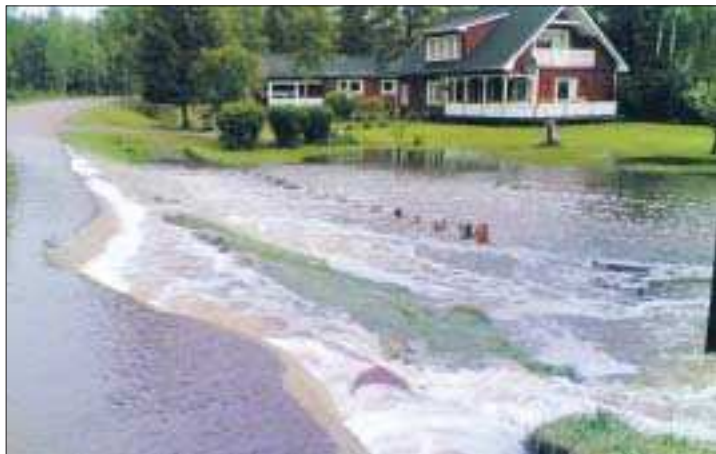
Vägen rasar. Berghamnsvägen i Hammarland Bovik rasade till hälften under tisdagens förmiddag. Bara halva körbanan blev kvar att köra på. Foto: SAIDA SJÖBLOM
