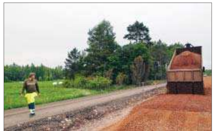
Lättare väg. Vid det här vägvägningsnittet ligger det 60 centimeter lecakulor i väggroppen under gruset. Syftet är att få en lättare väg som inte skall sjunka så fort ner i det upp till 20 meter djupa lerlagret. Foto: ANDREAS DIENERT
