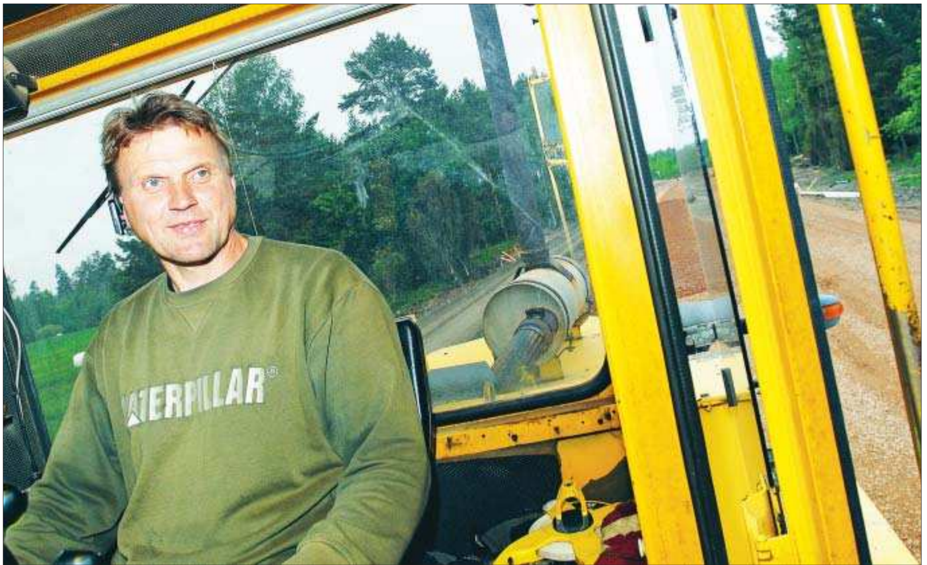
Sista draget. Arbetsledaren Erik Rosenberg vid firma Rolf Widman breder ut det sista gruset med vägghyveln på ombyggda landsväg 3 i Lumparland. Efter asfalteringen som inleddes den 14 juni, är hela sträckan mellan Mariehamn och Långnäs ombyggd till lättad för speciellt pendlarna i Lumparland. Foto: ANDREAS DIENERT
