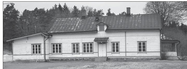
Blir skollokal. Mangårdsbyggnaden på Kastelholms kungsgård ska renoveras. Tanken är att en hantverksutbildning ska flytta in i den. Foto: CAROLA BOMAN
