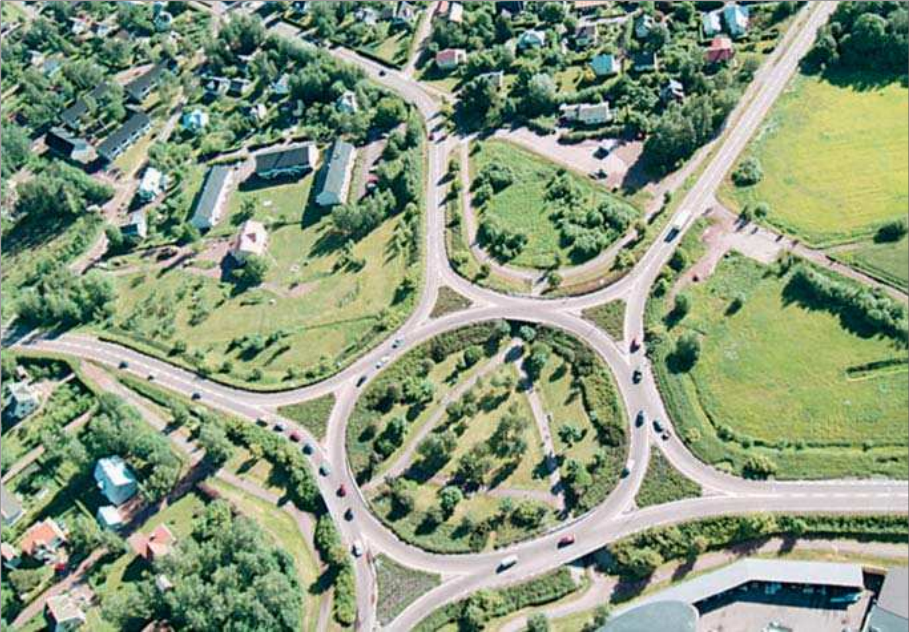
Ökad säkerhet. Att korsa vägen i Kvarnbo Saltvik är förenat med livsfara, skriver trafikminister Runar Karlsson. Därför planeras en minirondell i Kvarnbo. På bilden rökerirondellens vars syfte är däremot främst framkomlighet. Foto: STEFAN ÖHBERG
