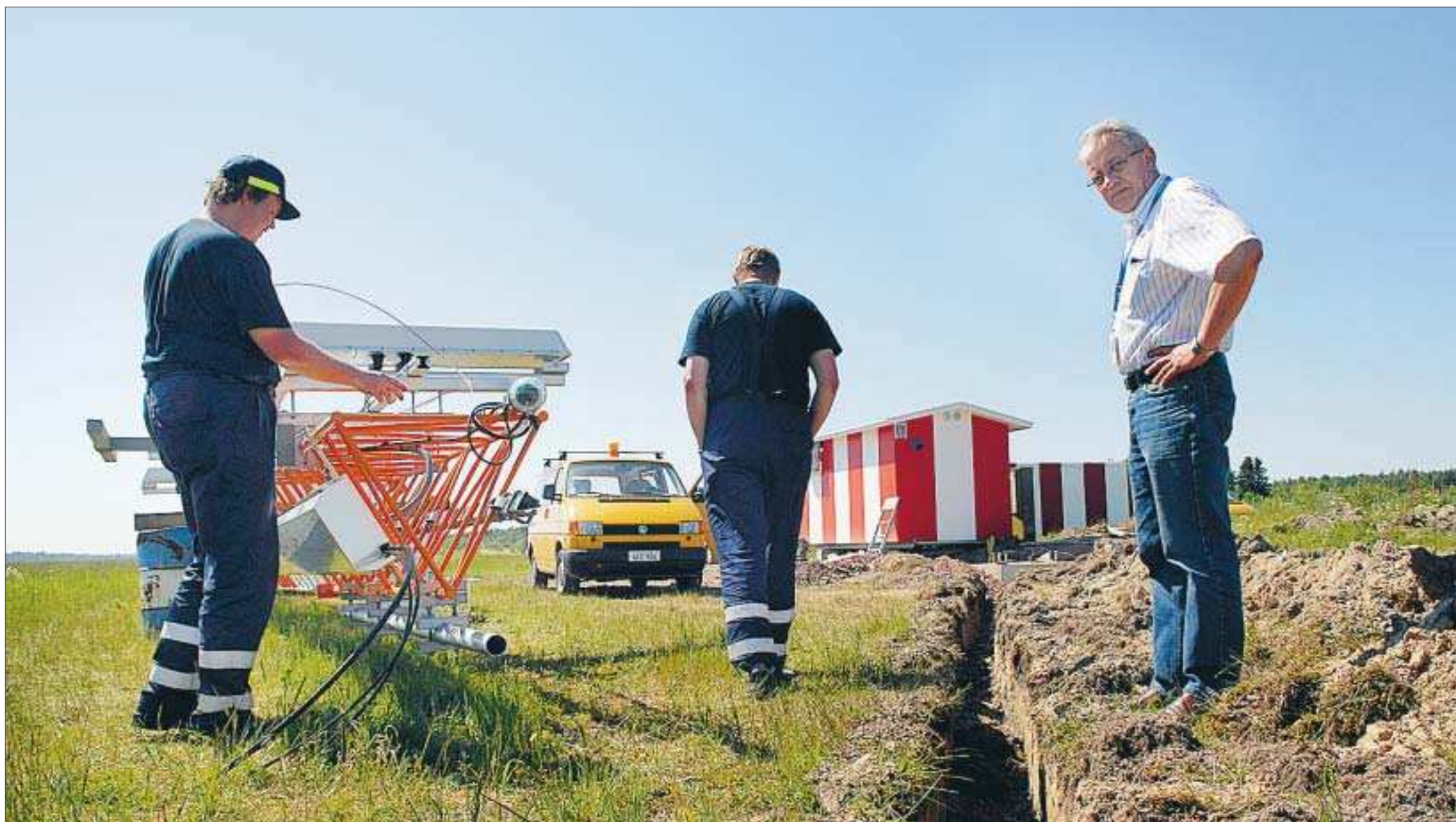
Bygge på gång. På det öppna flygfältet pågår mycket arbete, som här i den norra ändan av landningsbanan. Nytt fundament har gjutits för den nya antennen som ska resas men som än så länge ligger på marken. Diken har grävts för kablarna och det randiga servicehuset har bytts ut mot ett nytt. Antennarbetarna heter Pekka Rouvinen och Heikki Tamminen. Till höger tf flygplatschef Stig Aller.
