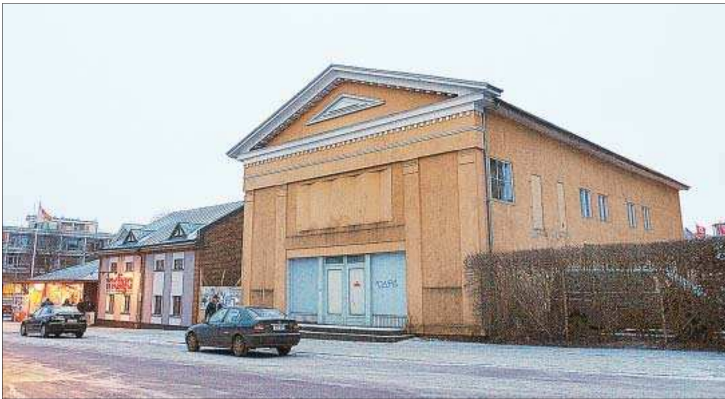
Ska bevaras. Kinoteatern i Mariehamn får byggas om, men inte till bostäder. Den här gavelfasaden måste bevaras.
