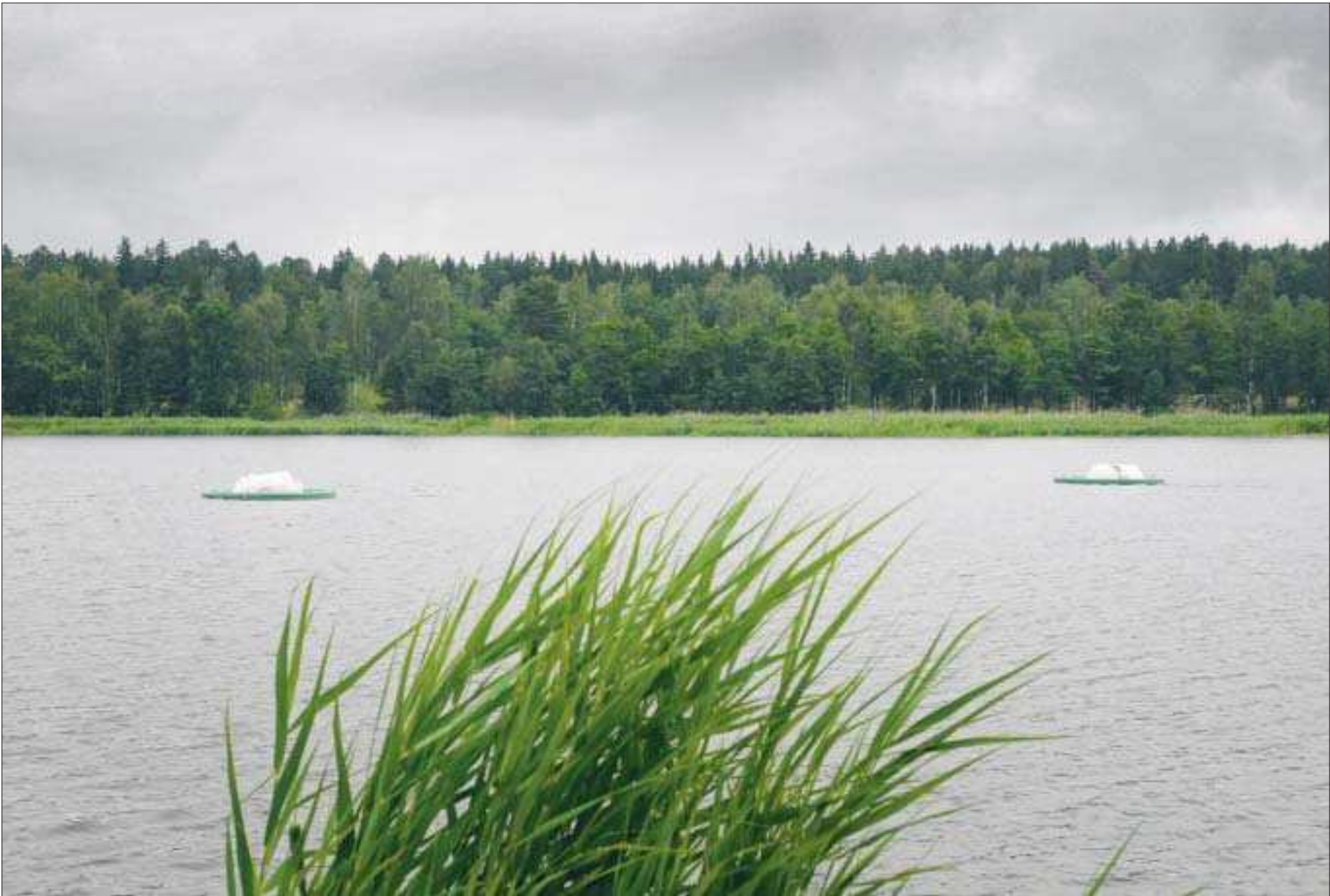
Pumpar upp vatten. Anläggningarna luftar bottenvattnet i Kaldersfjärden för att tillföra syre.
