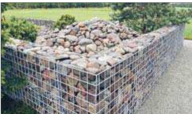
För hand. Ulf Nordefjell har radat stenarna i sin moderna mur för hand för att få dem så vackert lagda som möjligt.
