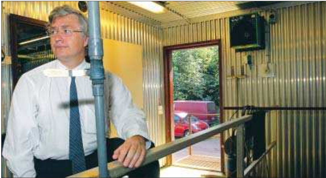
Kommundirektör. Jörgen Lundqvist inspekterar reningsverket. För att åtgärda utsläppsproblemen har man satt dygnet runt-jour och beställt en utredning av problemen från en svensk konsultfirma. Foto: ANDREAS DIENERT
