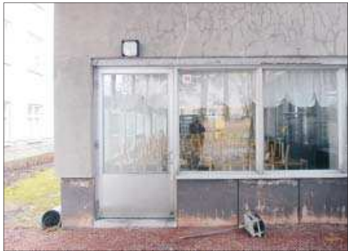
Rivs. ÅHS kök och matsal ska rivas och ge plats för nya hälsocentralen. Byggstart i början av nästa år.
