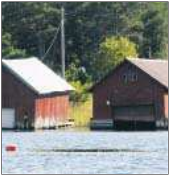
Så här såg det ut i augusti när avloppsledningen visade sig ovanför ytan.
