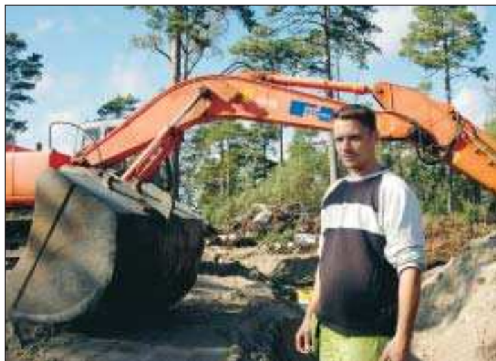
Ung. Magnus Söderlund är en av Ålands unga schaktentreprenörer. Han har entreprenaden för anläggandet av tekniken på Solberget.
