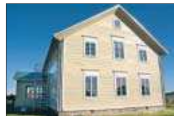
Som ny. Skeppargården Pellas är som ny igen.
