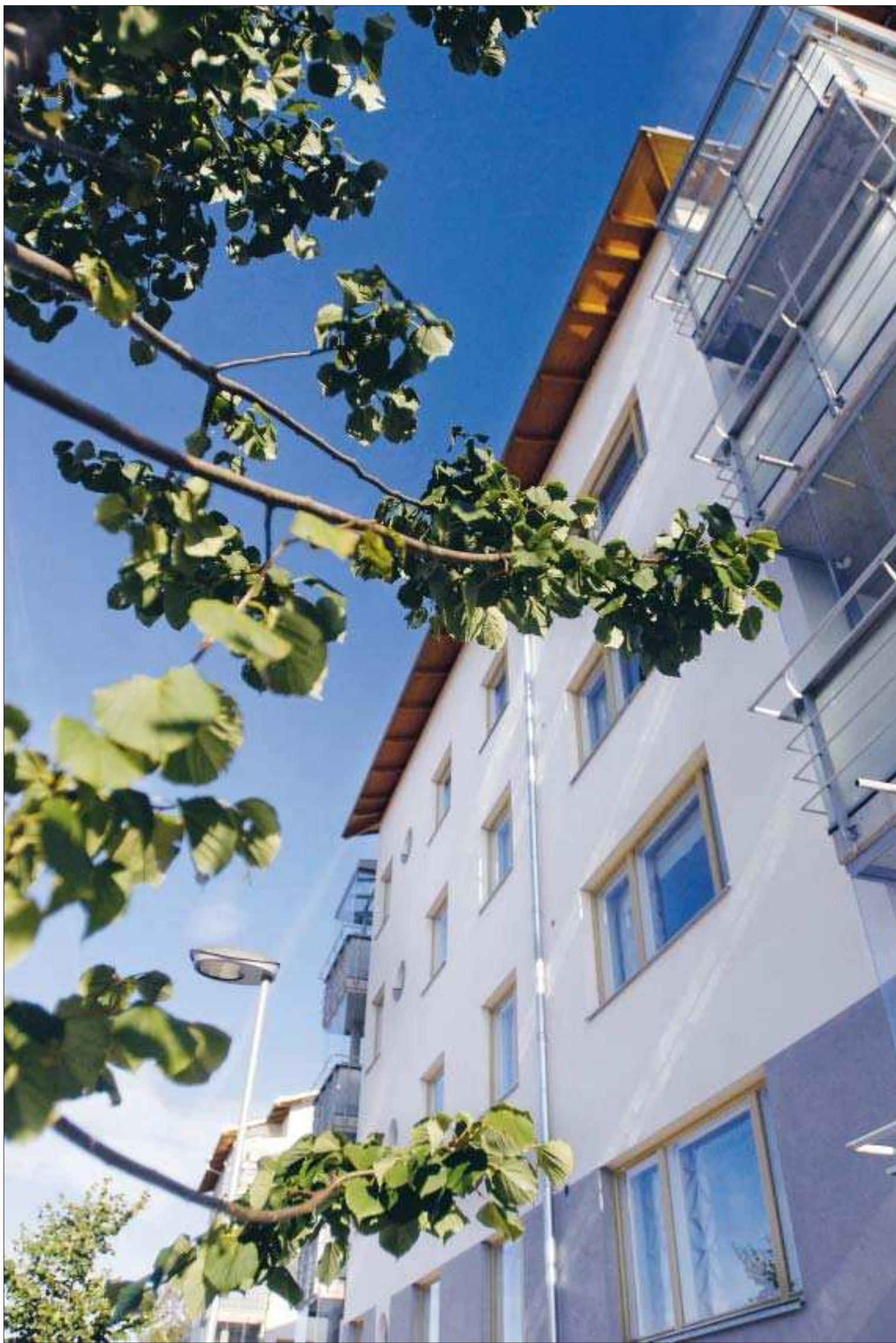
Fler på gång. I dag har Marstad två hyreshus vid Lotsgatan och tre till i samma stil är på kommande.
