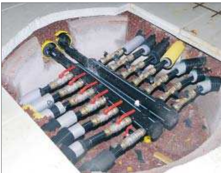
Sju rör. I den här brunnen i källaren samlas rören som borrats ner nästan 200 meter. Ovanpå läggs ett lock.
