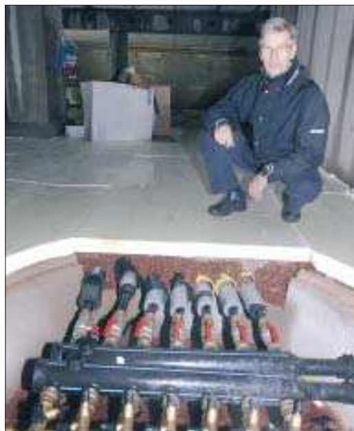
Rörbrunn. Här samlas de sju rör som ska förse det nya Ömsen-huset med värme, visar projektledare Bjarne Karlsson .
