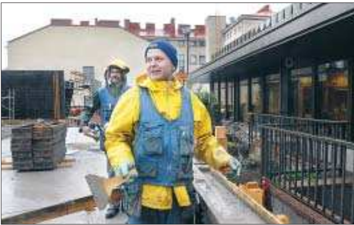
Ett år kvar. Ett knappt år återstår tills det stora Ömsen-huset ska vara inflyttningsklart. Affärer, kontor och hyresbostäder byggs. På bilden murar Lars Uppgård (närmast kameran) och Bo Ivarsson.
