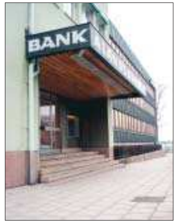
Ålandsbanken har fått lov av byggnadsnämnden att bygga till huvudkontoret i Mariehamn. Vissa inre ombyggnadsarbeten skall också utföras.
