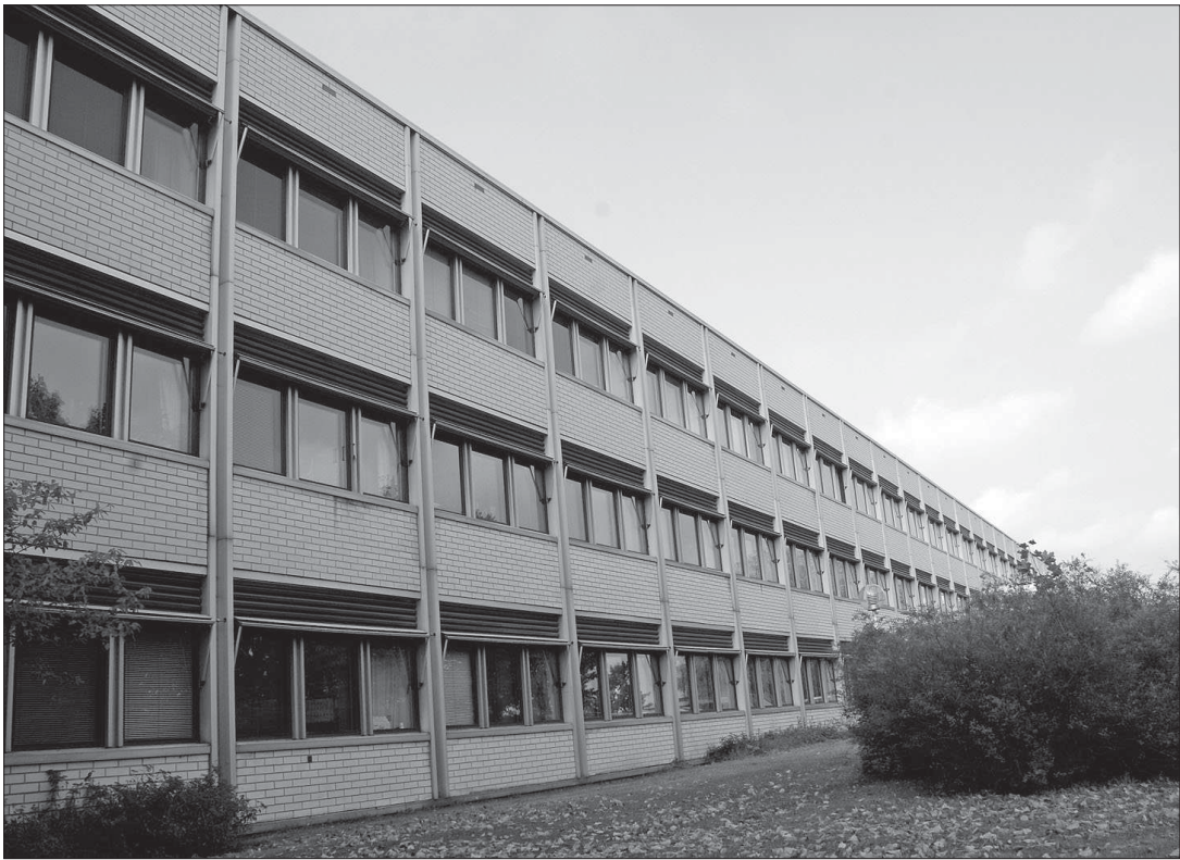
Rustas upp. Självstyrelsegården är en av flera fastigheter som landskapsregeringen vill renovera nästa år. Foto: FREDRIK TÖRNROOS
