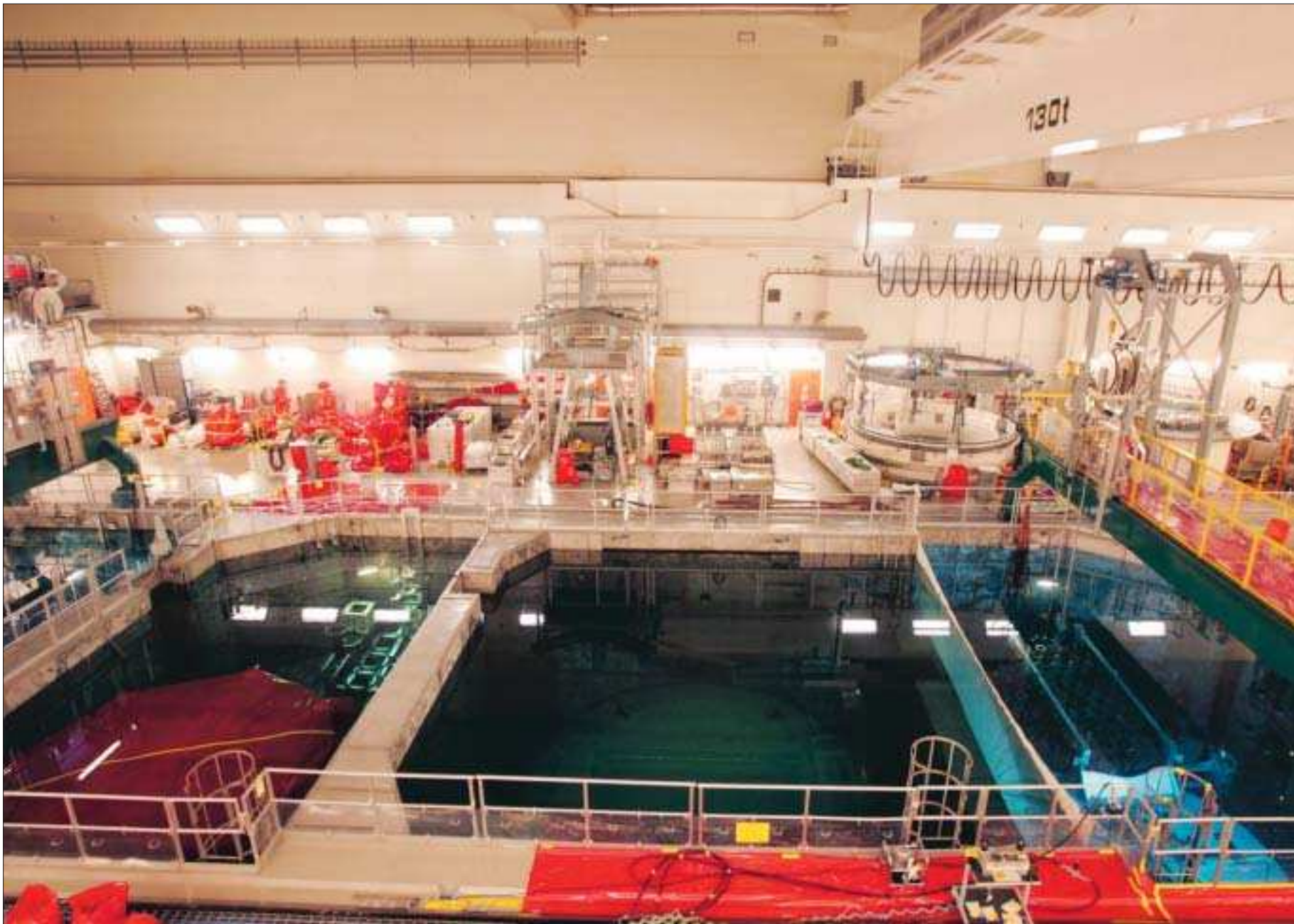
Reaktion. Ett stabilt elpris och säker tillgång, är orsaken till att elandelslaget köpt in sig i kärnkraftsbranschen. Det här är en interiör från reaktorhallen i kärnkraftverket i Olkiluoto. Foto: LEHTIKUVA
