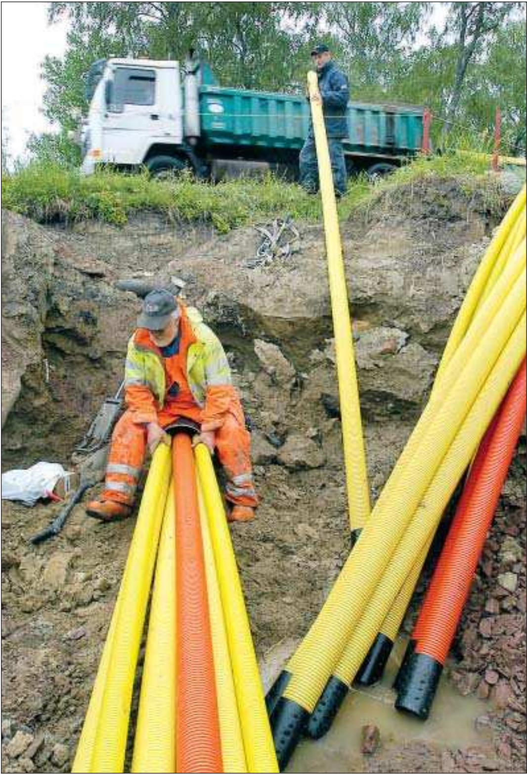
Inte enkelt. Alla energibeslut är svåra, men Ålands elandelslag gjorde ett misstag som trodde att en satsning på kärnkraft går att göra utan att folk reagerar. Här läggs det ut elkablar under landsväg 3. Arkivfoto: STEFAN ÖHBERG
