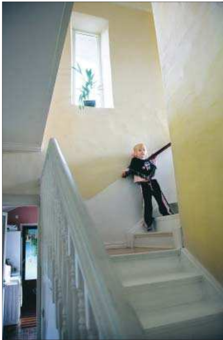
Levande ytor. De putsade halmväggarna ger ett levande intryck eftersom de inte är platta som skivväggar. Lucia i trappan till övervåningen.
