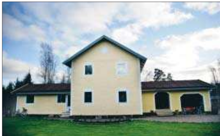
Ekohus. Huset är byggt av lokalt material så långt det har varit möjligt. Halmen kommer från Ytterby, leran är lokal och yttertakets är av filt – lätt att transportera. Familjen bor i mittdelen med extra utrymmen i flyglarna som inte behöver värmas vintertid.
