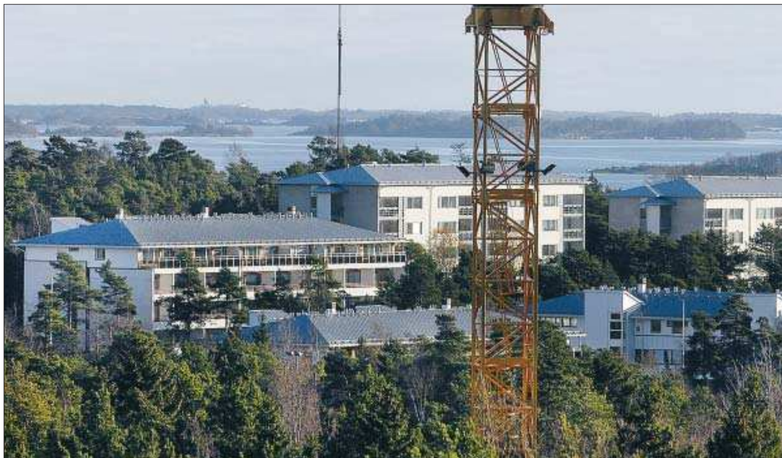
Lockande? Havsnära kan man bo i så gott som hela Mariehamn, men havsutsikt sådan den är på Lotsgatan bjuds inte överallt. Har Åland tillräckligt med natursköna platser för att kunna bygga litet mer havsnära och locka inflyttare utan att idén med Åland förstörs? Foto: ERKKI SANTAMALA
