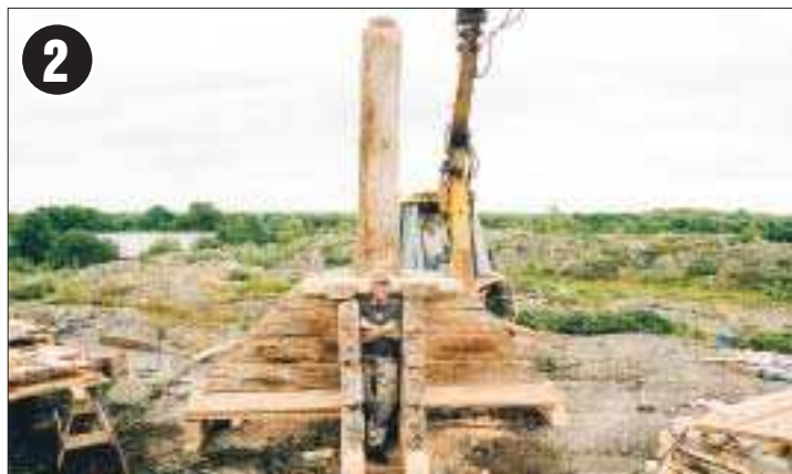
Bra början. Jan Henriksson tar en paus i jobbet och kollar läget inför en etapp av kvarnbygget.
