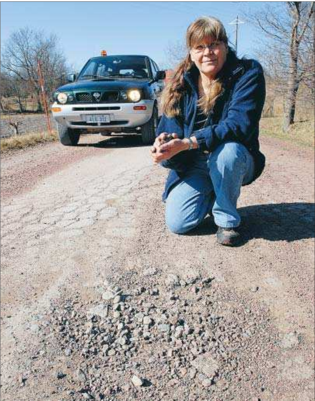
Skall förbättras. Geta kommun planerar få investeringar det kommande året. Den största investeringen blir att bygga till Hemgården. En mindre investering blir att grusa Dånövägen som i dag är i dåligt skick. Nya Åland följde med brevbäraren Gunnel Henriksson på en skumpig åktur längs vägen i somras. Arkivfoto: JONAS EDSVIK
