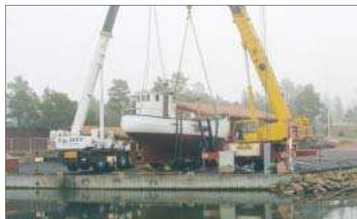
Ett och två och tre. Efter en timmes arbete med att fästa båten ordentligt lyfts hon.
