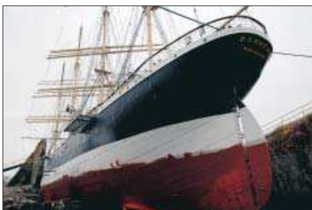
Stor nertill. Den som tittar på Pommern när hon ligger i vattnet ser inte den bulliga undersidan. Här finns det många nitar och mycket plåt som nöts oupphörligen.
