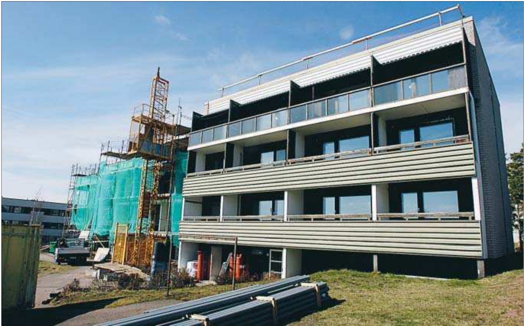
Hyresbostäder. Om man bor på hyra i landskapet är det dyraste alternativet ett våningshus i Mariehamn. Kvadratmeterpriset ligger i snitt på 8,22 euro i månaden. Två tredjedelar av de åländska hyresgästerna bor också i våningshus. Bilden är från en fasadrenovering av Skrakvägen 7. Arkivfoto: JONAS EDSVIK
