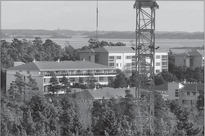
Hem till Lotsgatan. Fler och fler hus byggs på Lotsber-get i Mariehamn. Nu har bygglov getts till bostadsrättsföreningens bygge av 70 lägenheter. Bilden tagen från sjöbevakningstornet i november. Foto: ERKKI SANTAMALA
