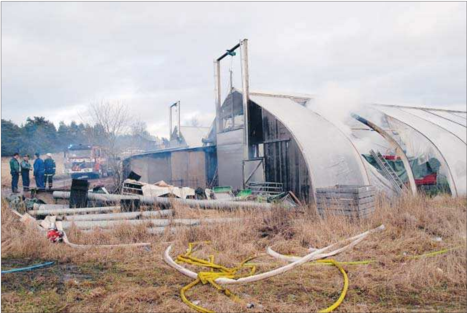
Brände hål. Växthusets tak smalt och fick ett stort hål ovanför den plats där traktorsläpet stod.
