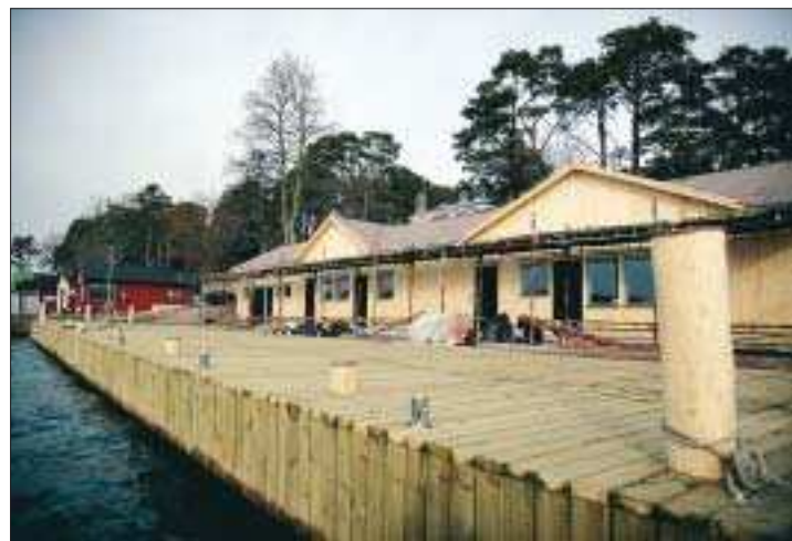
Seglingscenter. Den nya byggnaden vid ÅSS skapar en naturlig samlingsplats för seglare, båt-gäster och ålänningar.
