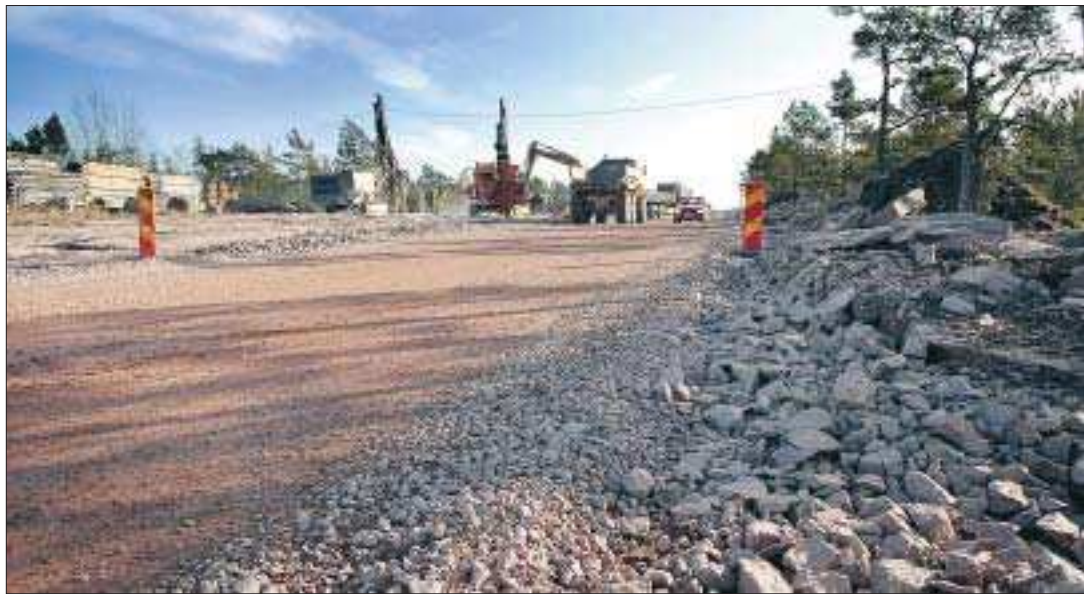
Gått undan. Vägbygget i Eckerö ligger långt före tidsplanen. I höst väntar den sista etappen att påbörjas på hela sträckan Mariehamn-Storby. Foto: JONAS EDSVIK
