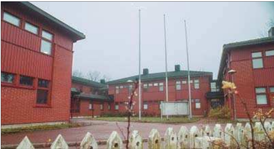
Drabbad. "Kommunförbundet uppger att var femte offentlig byggnad i Finland har fuktskador." skriver insändarskribenten. På bilden hälsocentralen innan renoveringen och saneringen.
