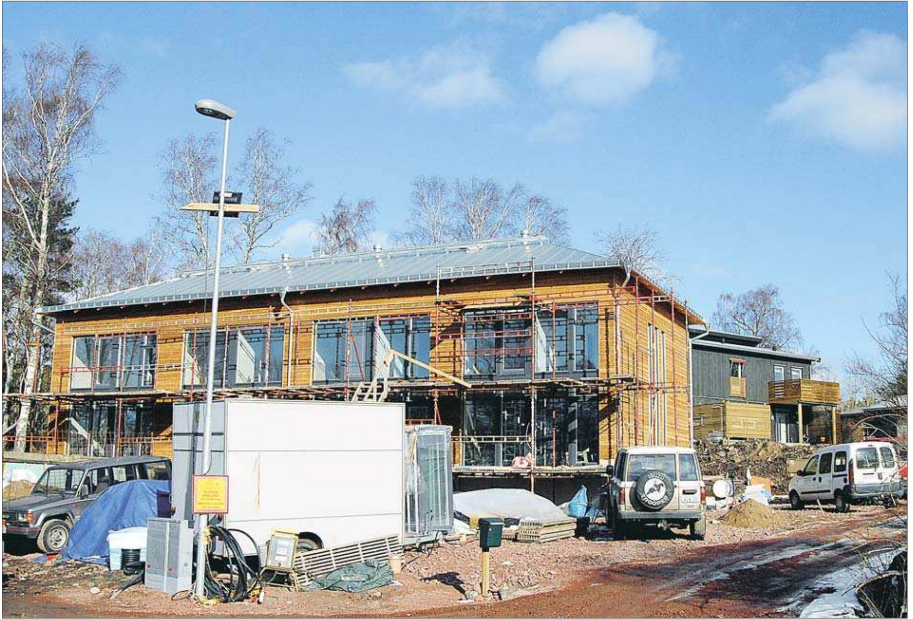
Fiskargränd. På Fiskargränd 5, 6 och 8 i Fiskehamnen är bygget i full gång. Huset längst ner mot vattnet står som skelett medan sexan redan ser rätt färdig ut.
