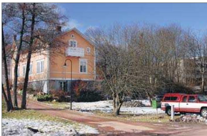
Norra Esplanadgatan 15 A. I västra änden av Esplanaden skulle det kunna byggas ett hus till.
