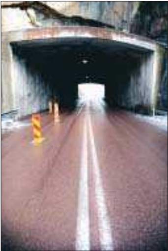
Färjsundstunneln har fått nya räcken för att om möjligt undvika olyckor i framtiden. Foto: ANDREAS DIENERT
