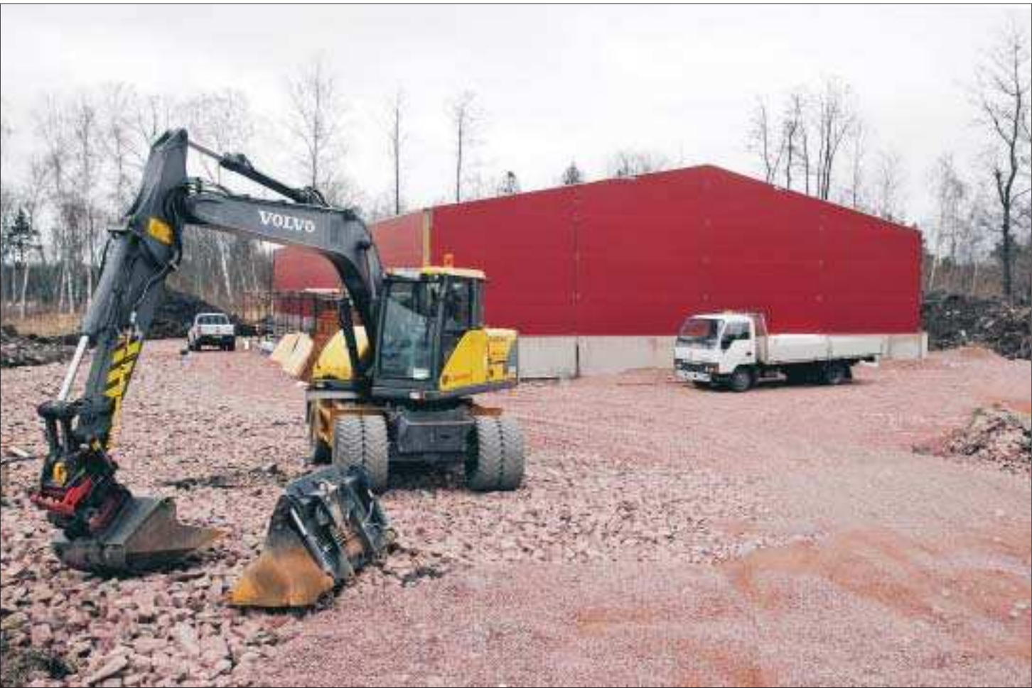
Industriområdet växer. Allt fler företag flyttar till Jomala Möckelö, ett av dem är SAJ instruments som köpt 3.000 kvadratmeter av kommunen och bygger en industri- och kontorslokal.
